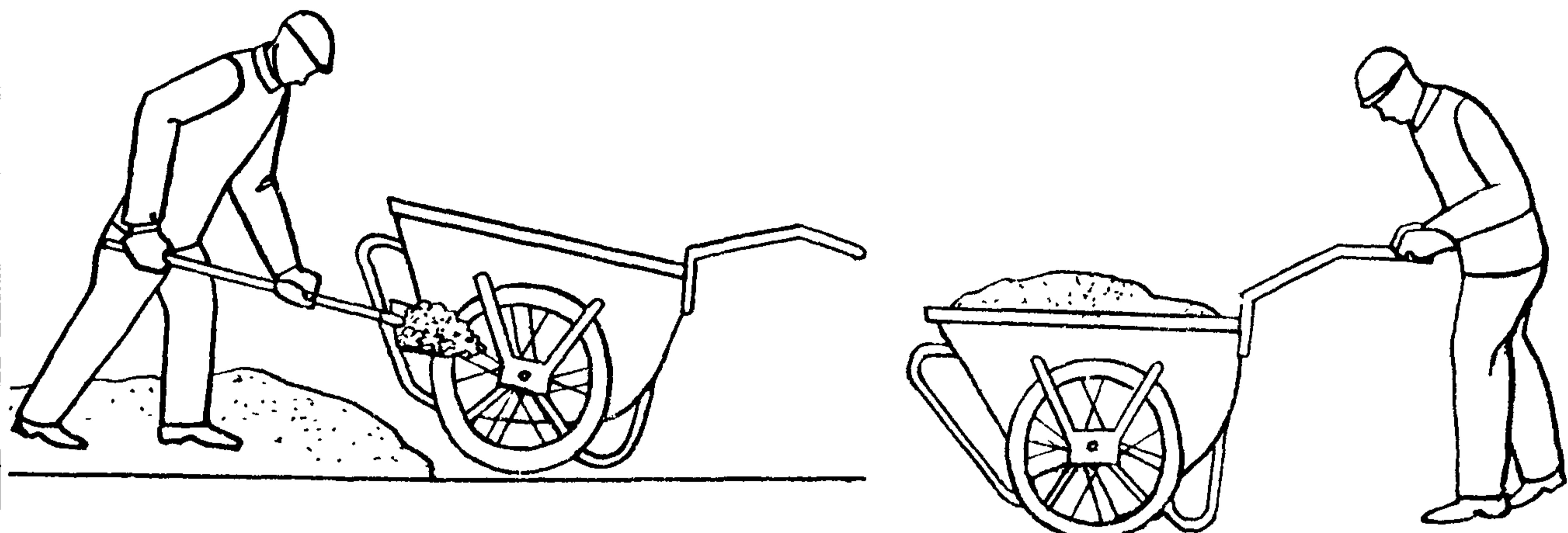
Кровельщики К<sub>2</sub> и К<sub>3</sub> лопатами загружают гравий в тележки и подвозят его к месту укладки
