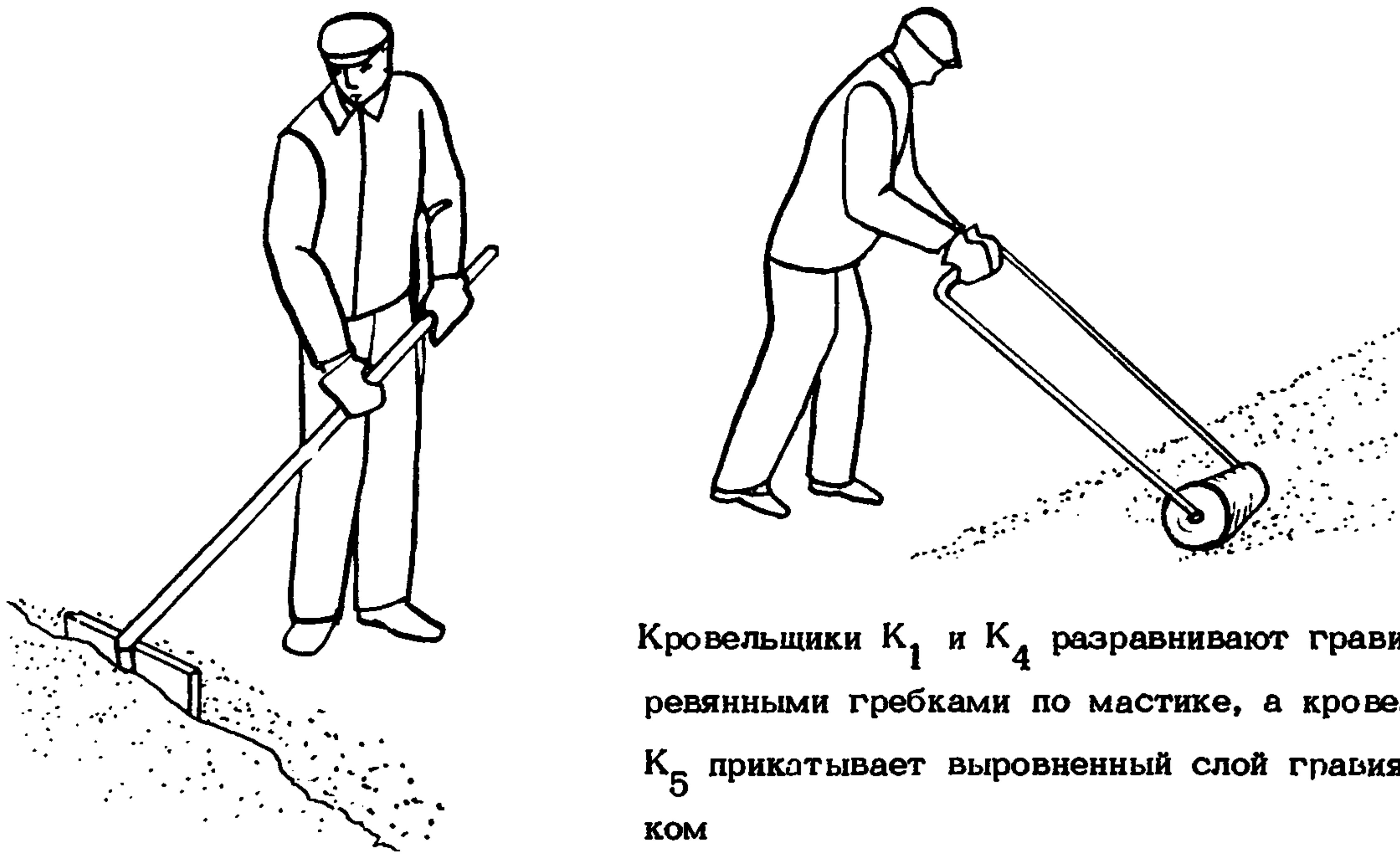
Кровельщики К<sub>1</sub> и К<sub>4</sub> разравнивают гравий деревянными гребками по mastике, а кровельщик К<sub>5</sub> прикатывает выровненный слой гравия катком
