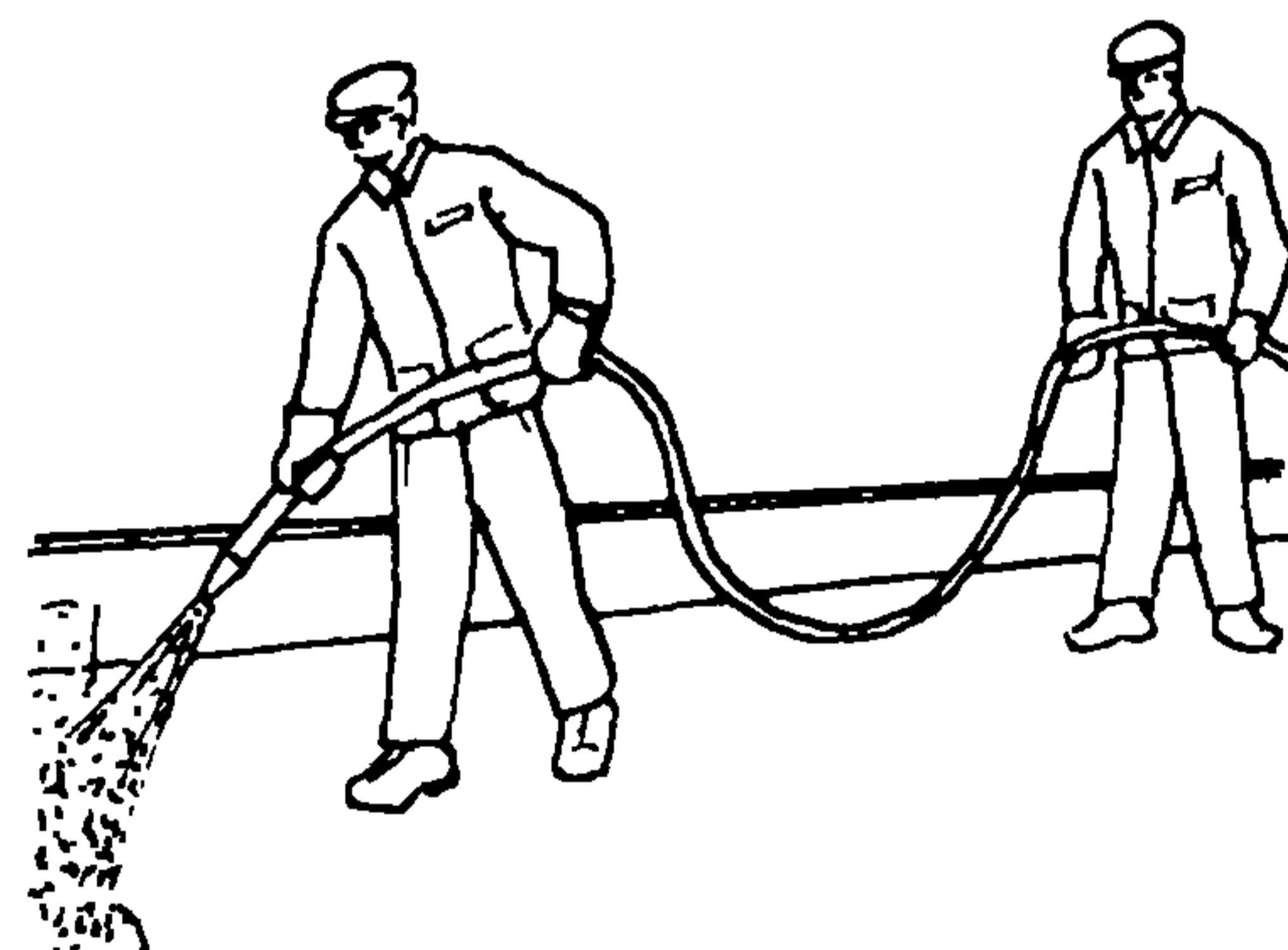
Изолировщик  $I_1$  при помощи бескомпрессорной форсунки наносит мастику ровным слоем на поверхность основания. Изолировщик  $I_3$ , двигаясь вслед за изолировщиком  $I_1$ , переносит по ходу работ шланги
