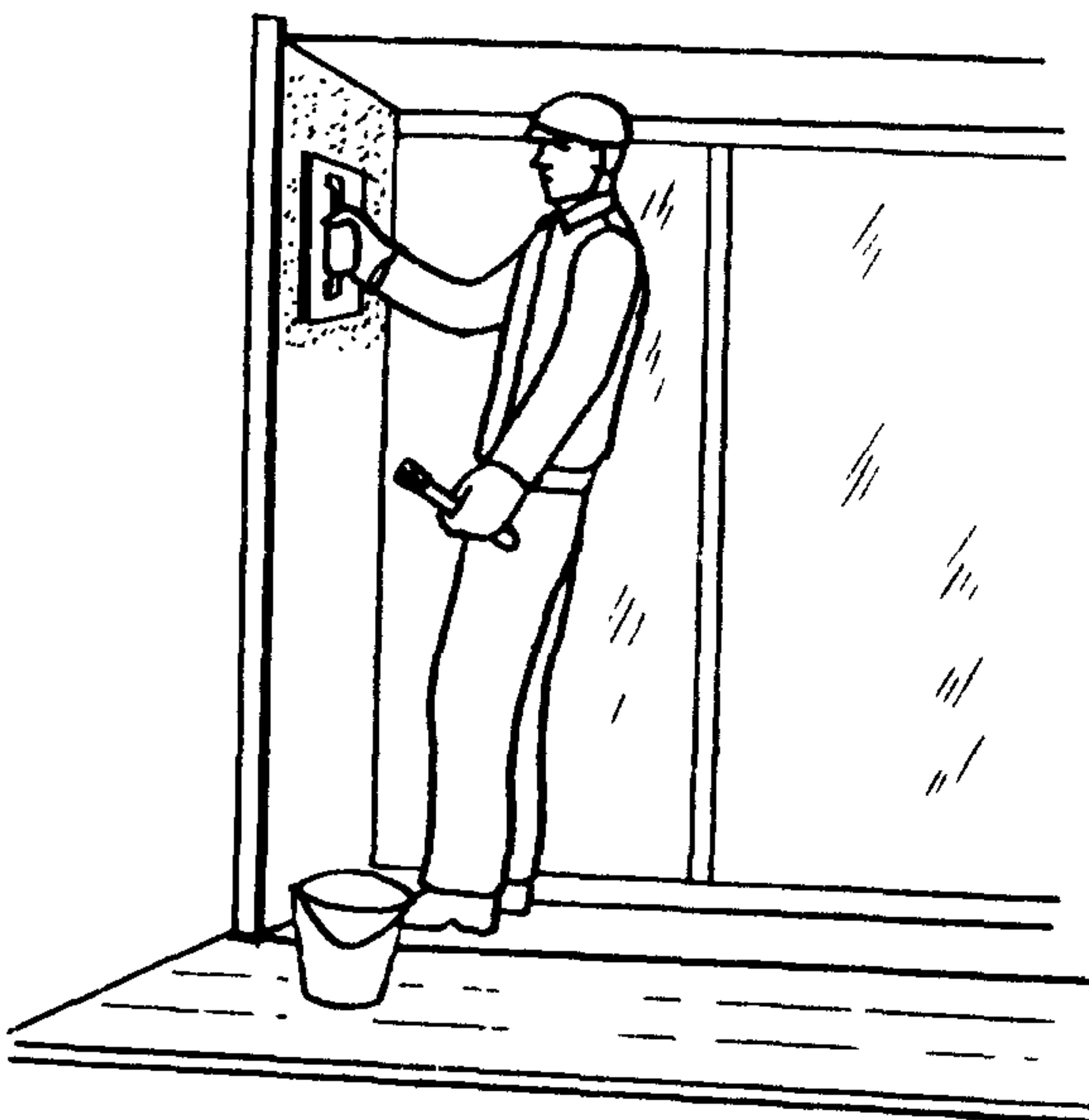
Подготовив раствор, штукатуры  $Ш_{20}$  и  $Ш_{22}$ ,  $Ш_{21}$  и  $Ш_{23}$  кельмами набирают его из ящика на соколы и наносят на откосы. Затем они выравнивают и затирают терками поверхность откосов, периодически смачивая их водой. Вертикальность и горизонтальность выровненной поверхности штукатуры проверяют с помощью отвеса, угольника и уровней
