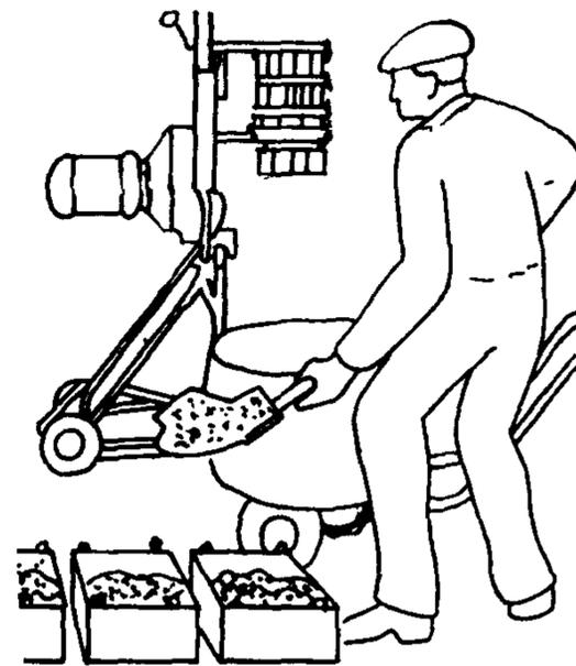
4 НАНЕСЕНИЕ ТРЕХ СЛОЕВ РАСТВОРА; 67 мин; Ш<sub>1</sub>, Ш<sub>2</sub>; пневматические машинки, компрессор, ковши, ведро
