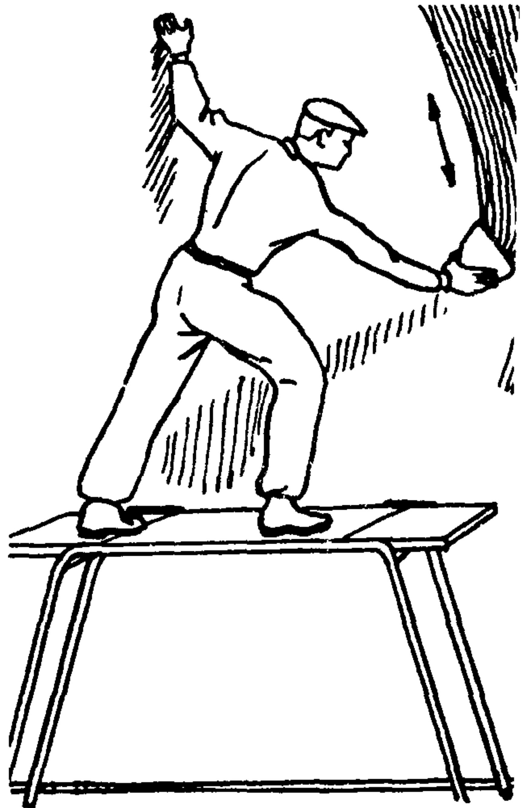
и снизу вверх обрабатывает правую часть участка. Затем перекладывает шпатель в левую руку и повторяет операцию в обратном направлении (слева направо), причем в этом случае упором служит правая рука. Нанесение шпаклевки у плинтусов маляр выполняет так: слегка согнувшись, присев и наклонившись вправо он прикладывает вытянутую правую руку со шпателем к поверхности стены у плинтуса;
