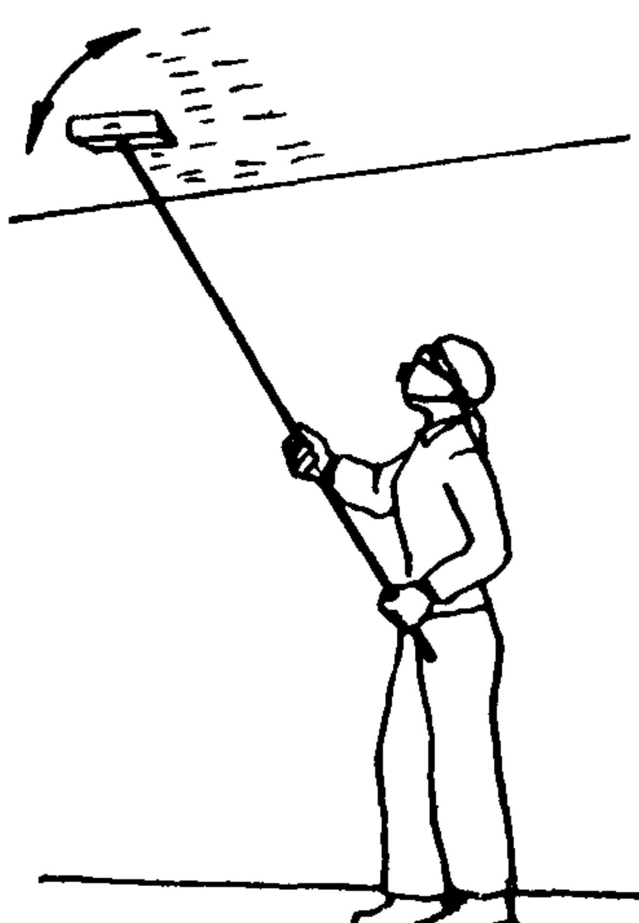
Каждый из маляров берет шлифовальное приспособление и, слегка нажимая на рукоятку, поступательно-возвратными движениями шлифует поверхность потолка. Отшлифовав полосу по ширине делянки, малляр продвигается на шаг вперед и шлифует следующую полосу. Затем малляр движениями кисти влево и вправо сметает пыль с поверхности потолка. По ходу работ он двигается назад. Угол наклона кисти к поверхности потолка равен примерно  $45^\circ$
