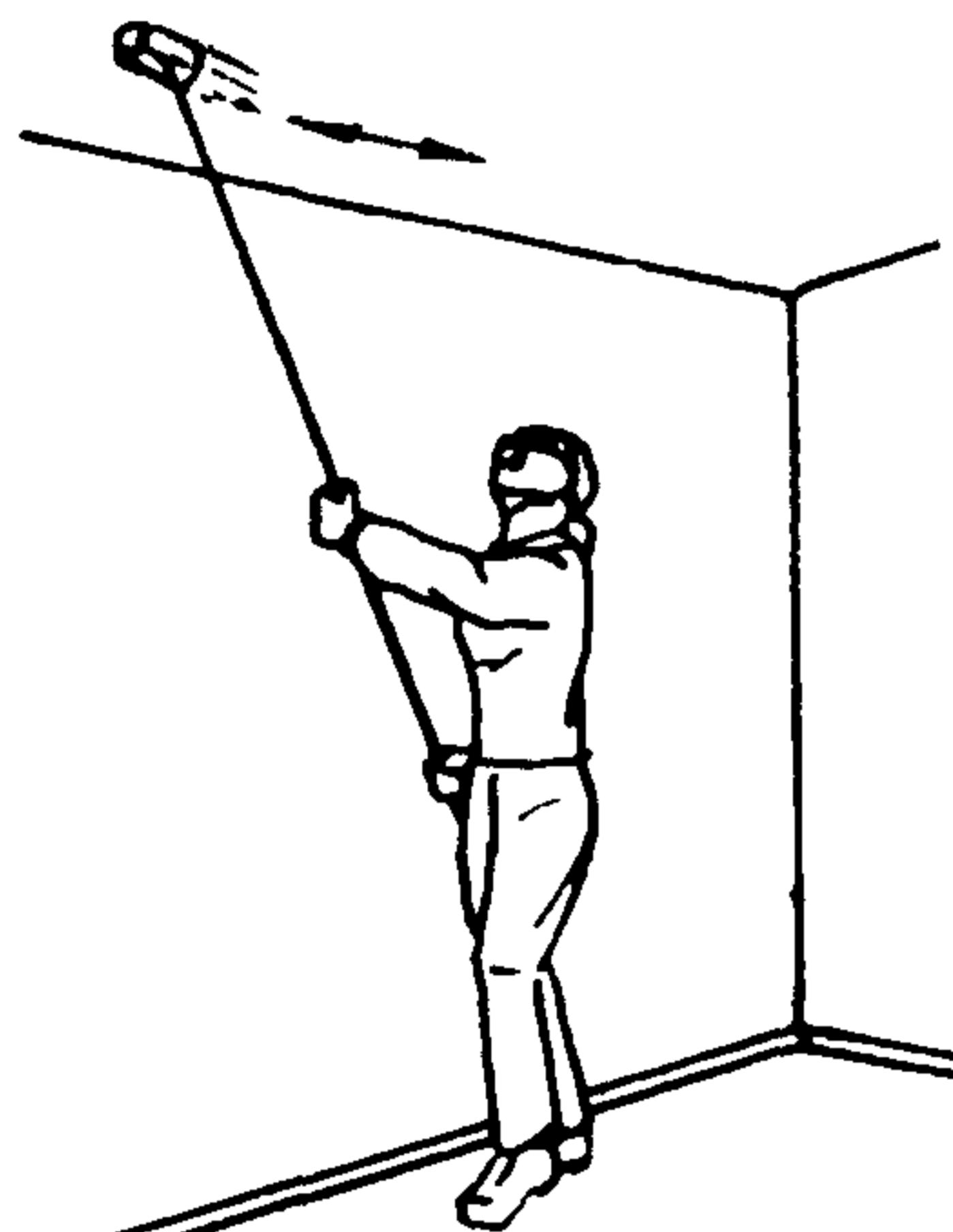
Маляры  $M_1$  и  $M_2$ , держа шлифовальные приспособления так же, как скребок, прикладывают их рабочие части к обрабатываемой поверхности потолка и поступательно-возвратными движениями сглаживают ее, продвигаясь по мере работы вперед.
