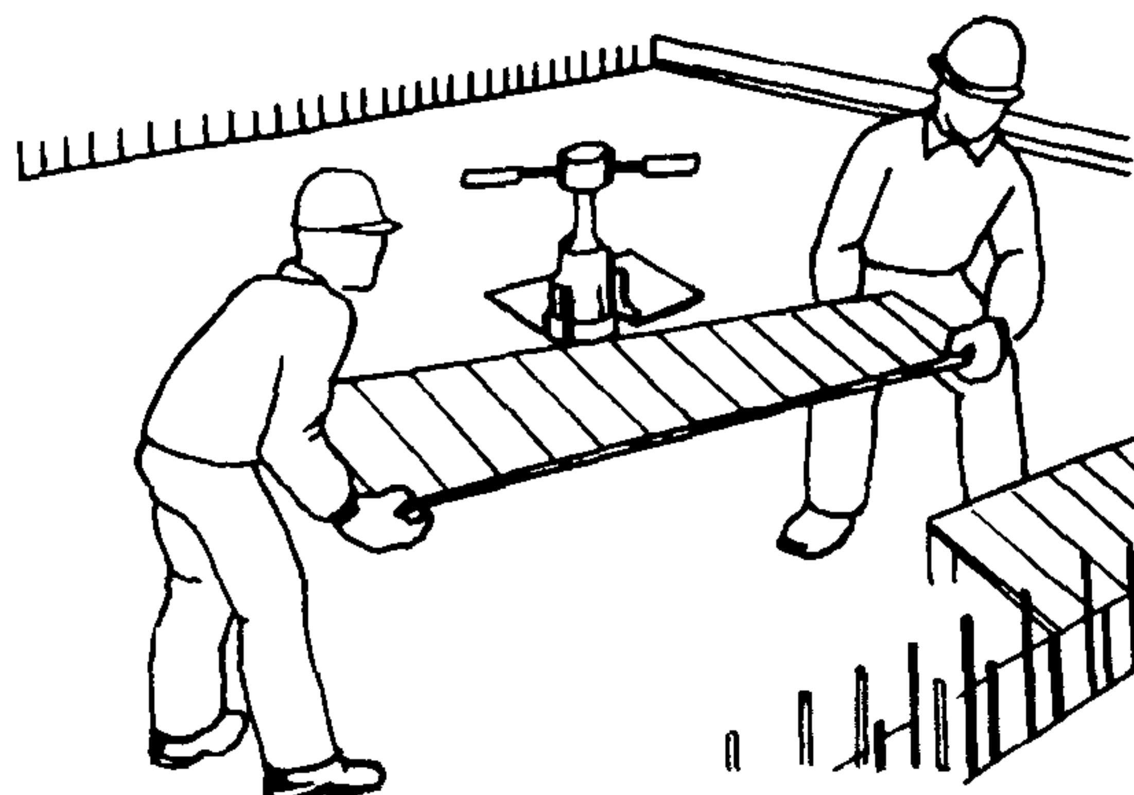
Бетонщики Б<sub>1</sub> и Б<sub>2</sub> устанавливают деревянные лотки по контуру настила опалубки впритык друг к другу
