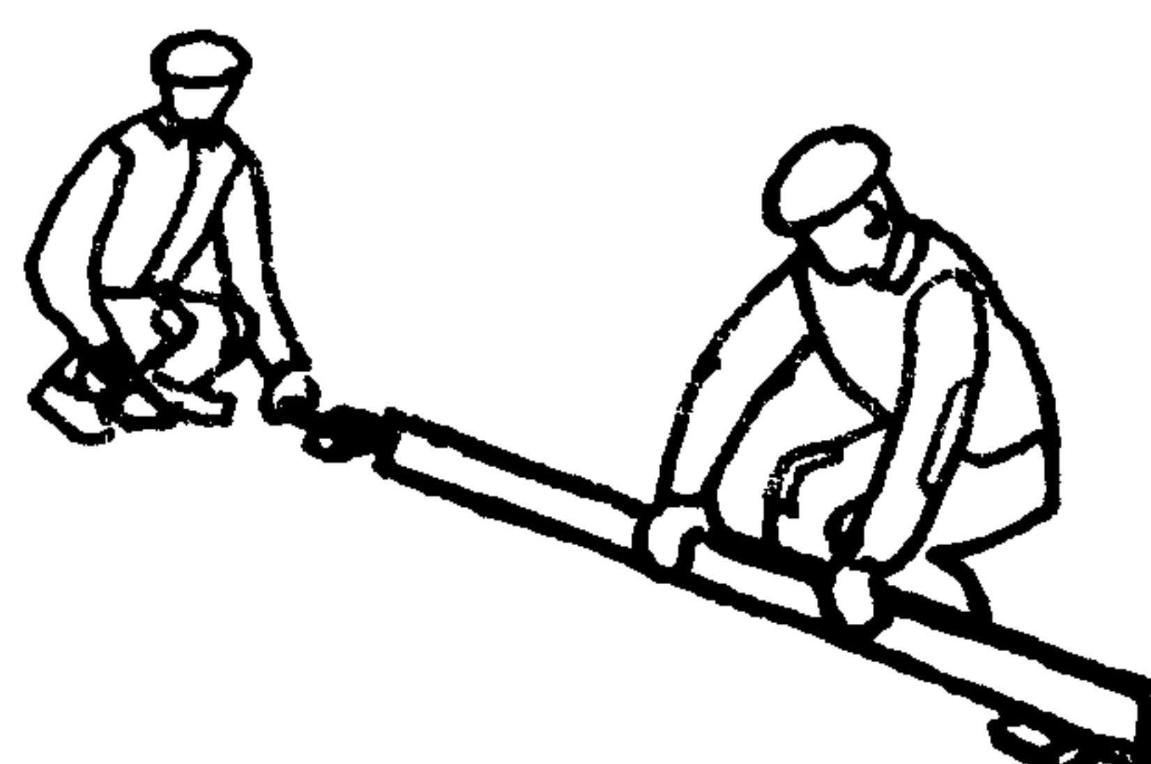
Бетонщики Б<sub>1</sub> и Б<sub>2</sub> укладывают маячную рейку на маяки из раствора, проверяя правильность укладки по уровню, и закрепляют ее с обеих сторон раствором
