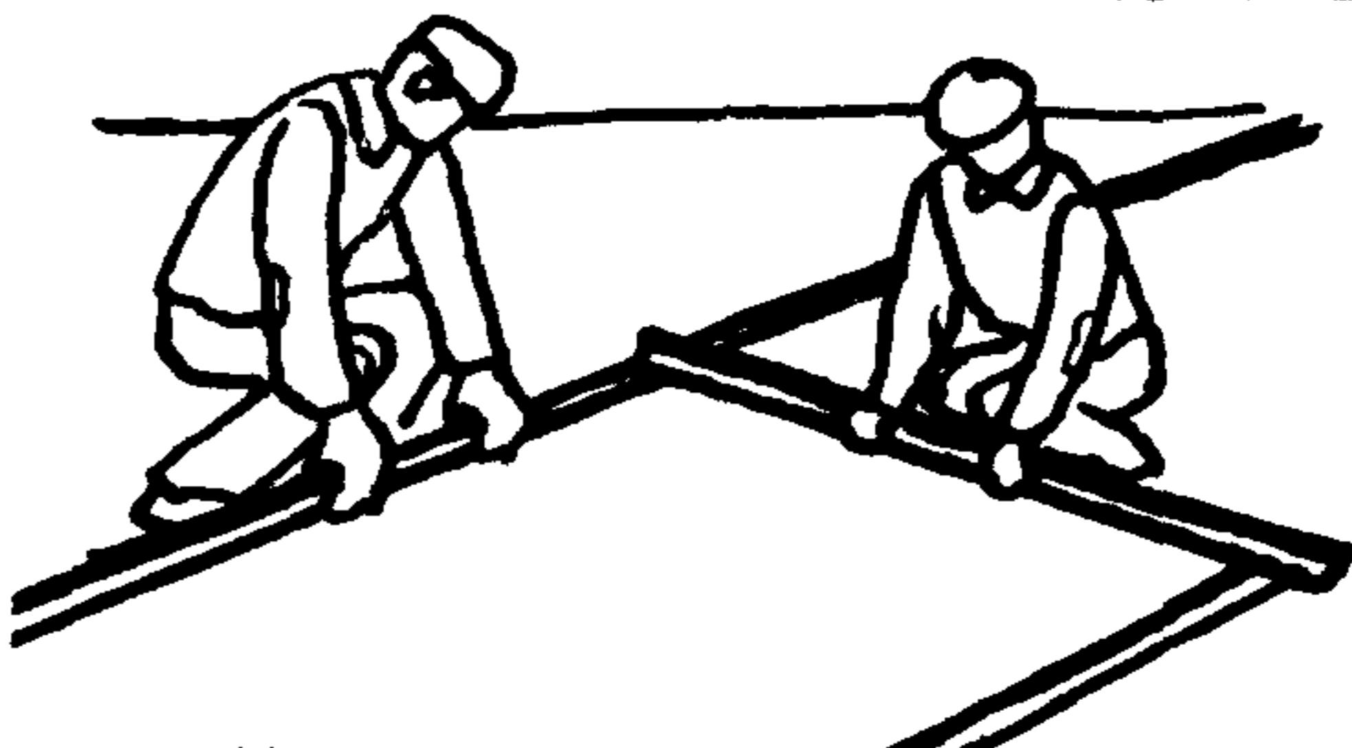
Бетонщик  $B_1$  укладывает один конец контрольной рейки с уровнем на первую маячную рейку, а второй конец – на параллельную укладываемую рейку. Бетонщик  $B_2$  по команде бетонщика  $B_1$  регулирует уровень второй рейки при помощи маяков из раствора
