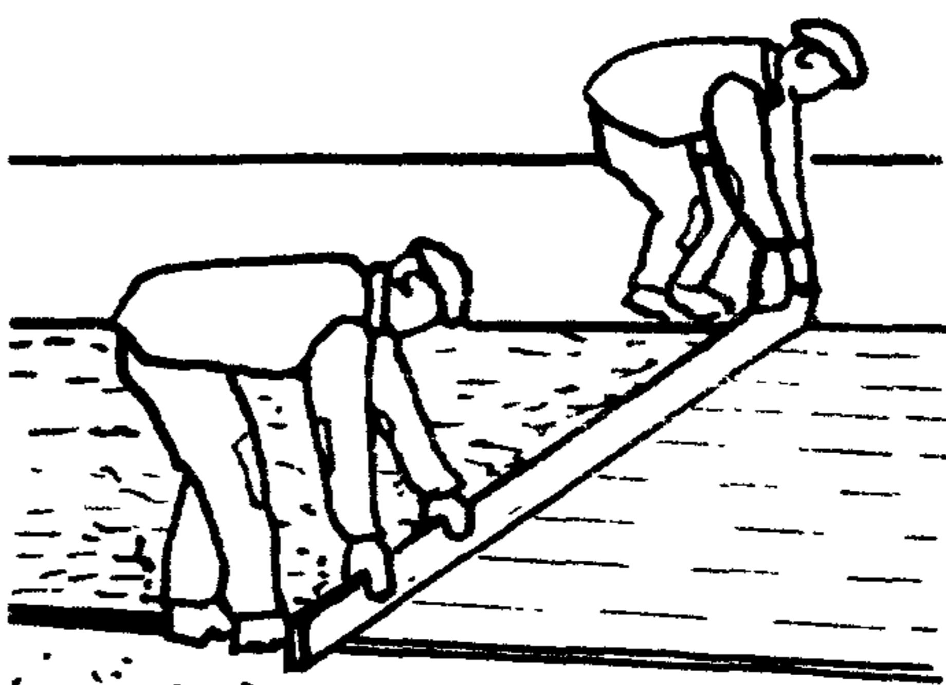
Бетонщики  $B_1$  и  $B_2$ , взявшись за концы правила, передвигают его по уложенным маячным рейкам зигзагообразными движениями, разравнивая раствор. Отдельные места они выравнивают полуторками
