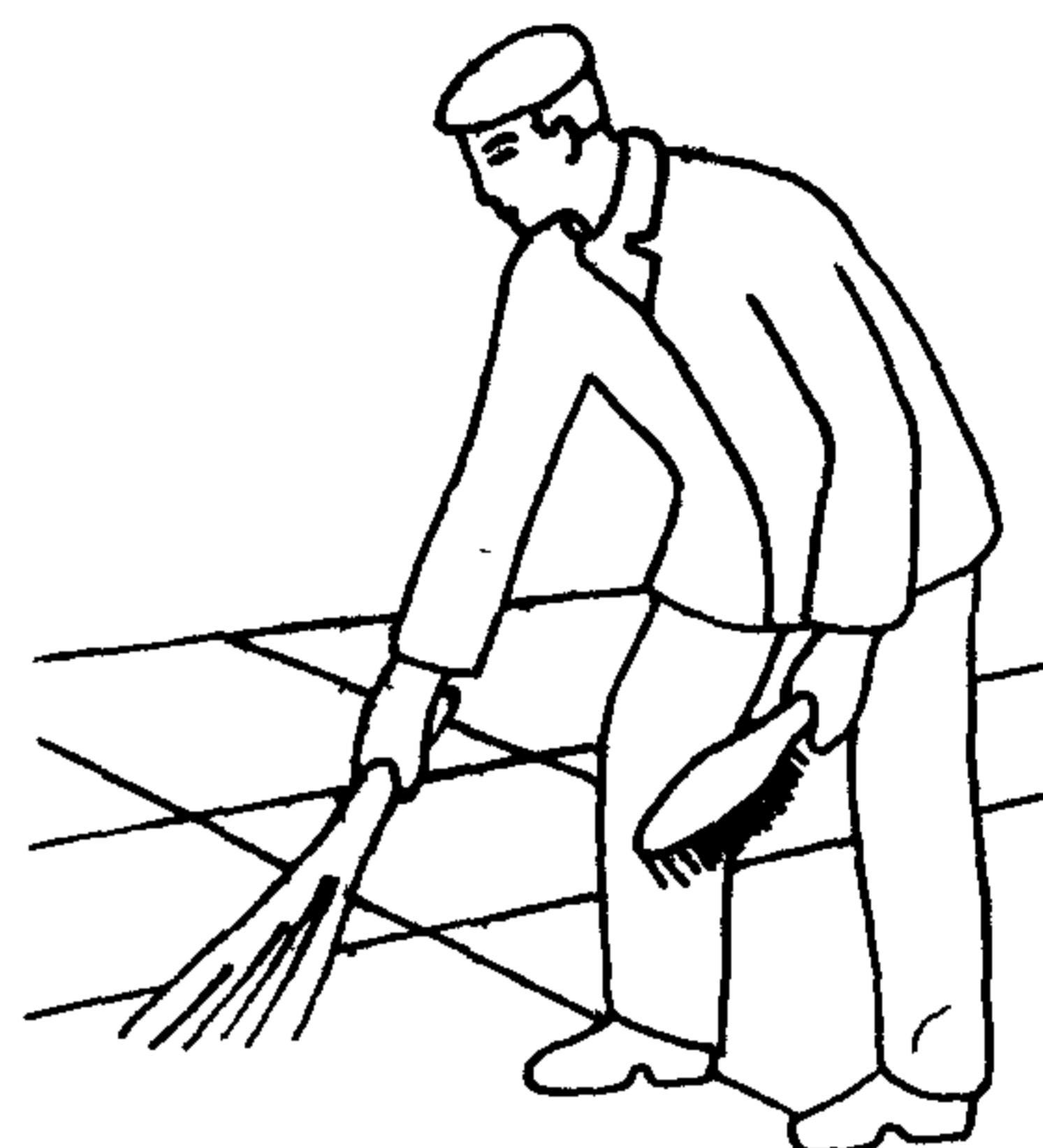
Облицовщик веником сметает с покрытия пола шлам, одновременно дочищая стальной щеткой отдельные места
