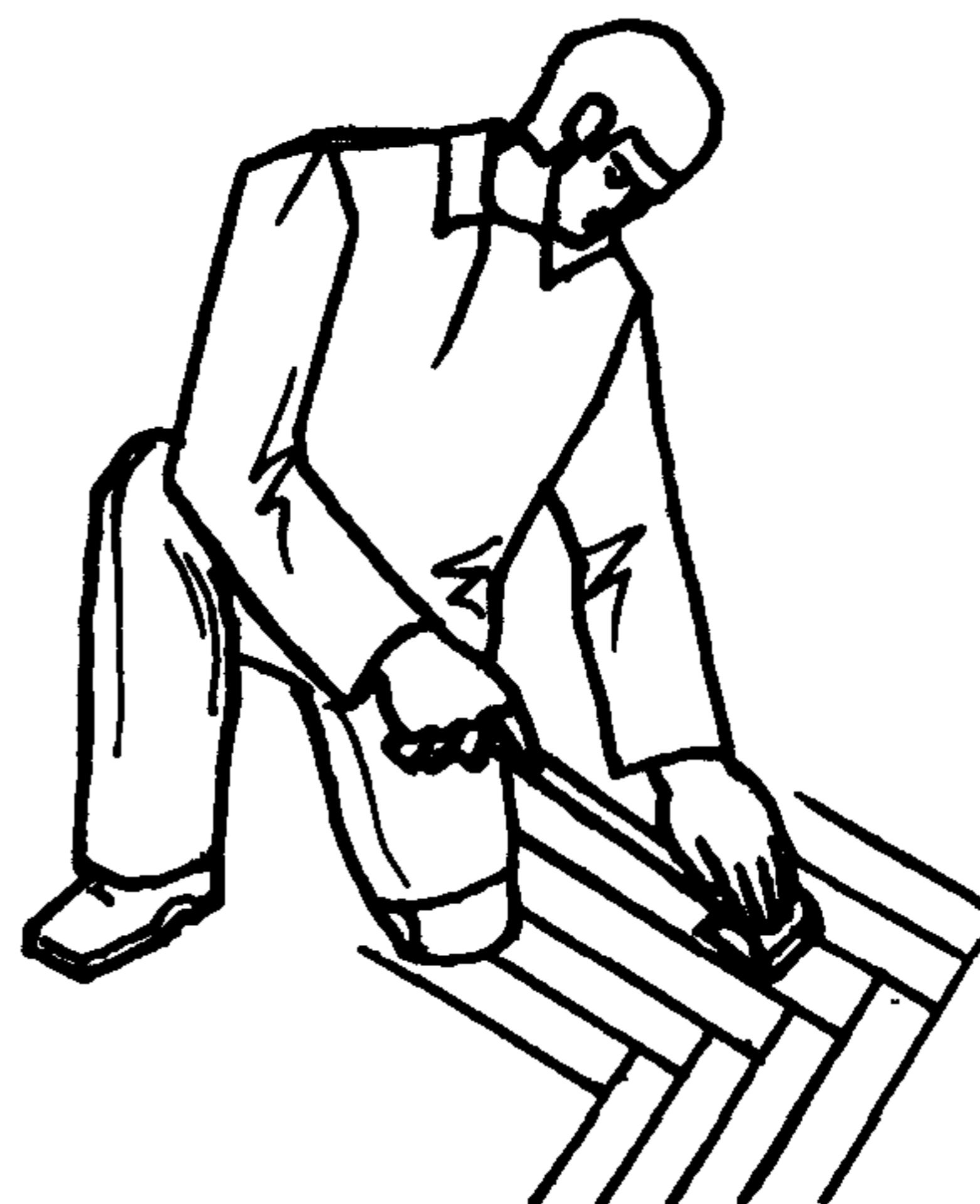
2 ШЛИФОВКА ПОЛА; 8,5 мин;  $\Pi_1$ ,  $\Pi_2$ ; паркетошлифовальные машины
