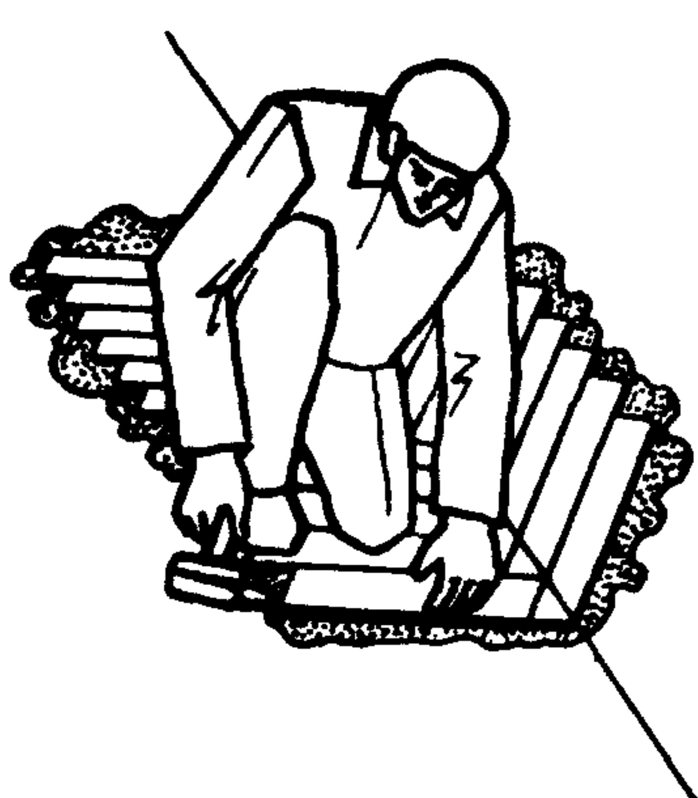
Паркетчик П<sub>2</sub> укладывает на мастику подготовленное звено клепок так, чтобы левый ряд маячной "елки" находился под шнуром, а углы правого ряда клепок – на линии шнура. Угол между ребрами паркетных клепок и шнуром должен составлять 45°. От уложенного первого звена паркетчик продолжает укладку маячной "елки" строго по шнуру, сплачивая клепки ударами молотка
