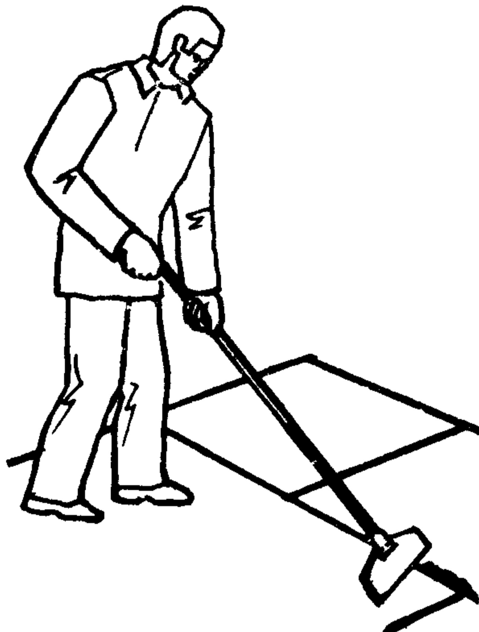
**4 ОГРУНТОВКА ПОВЕРХНОСТИ ПЛИТ; 2,5 мин; П<sub>1</sub>, П<sub>2</sub>; капроновые щетки, ванночки с сетками, пылесос**
