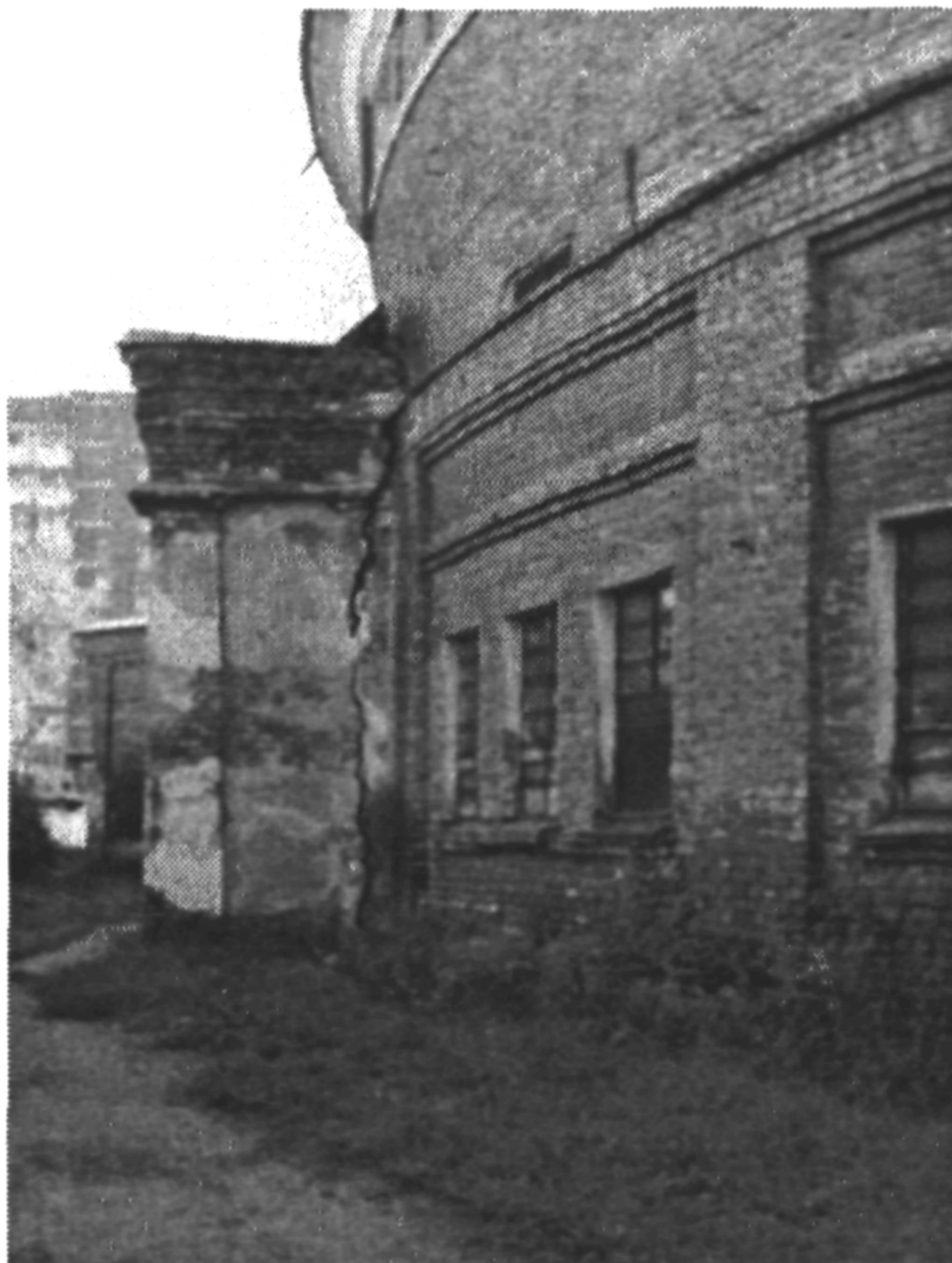
*Рис. 28. Отделение выходного тамбура от стены Ижевского цирка.*
