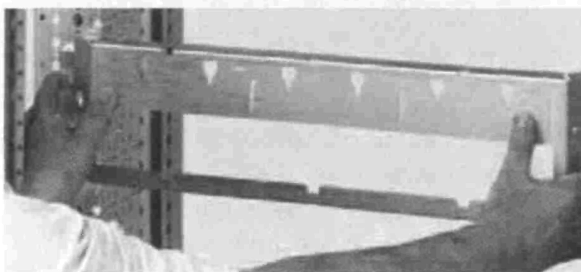
Рис. 6.4.4. Установка монтажной пластины.
