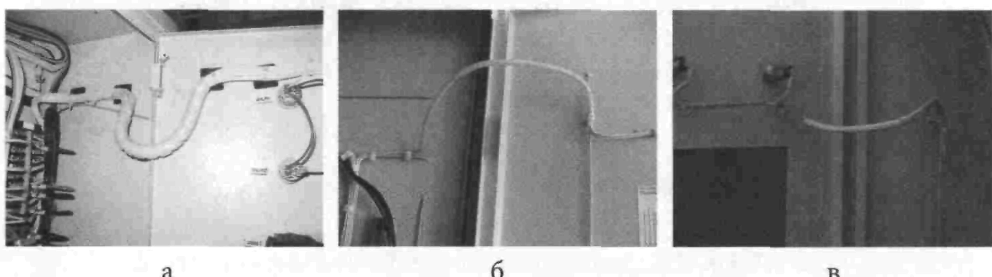
Рис. 8.4.1. Переход на подвижную часть
