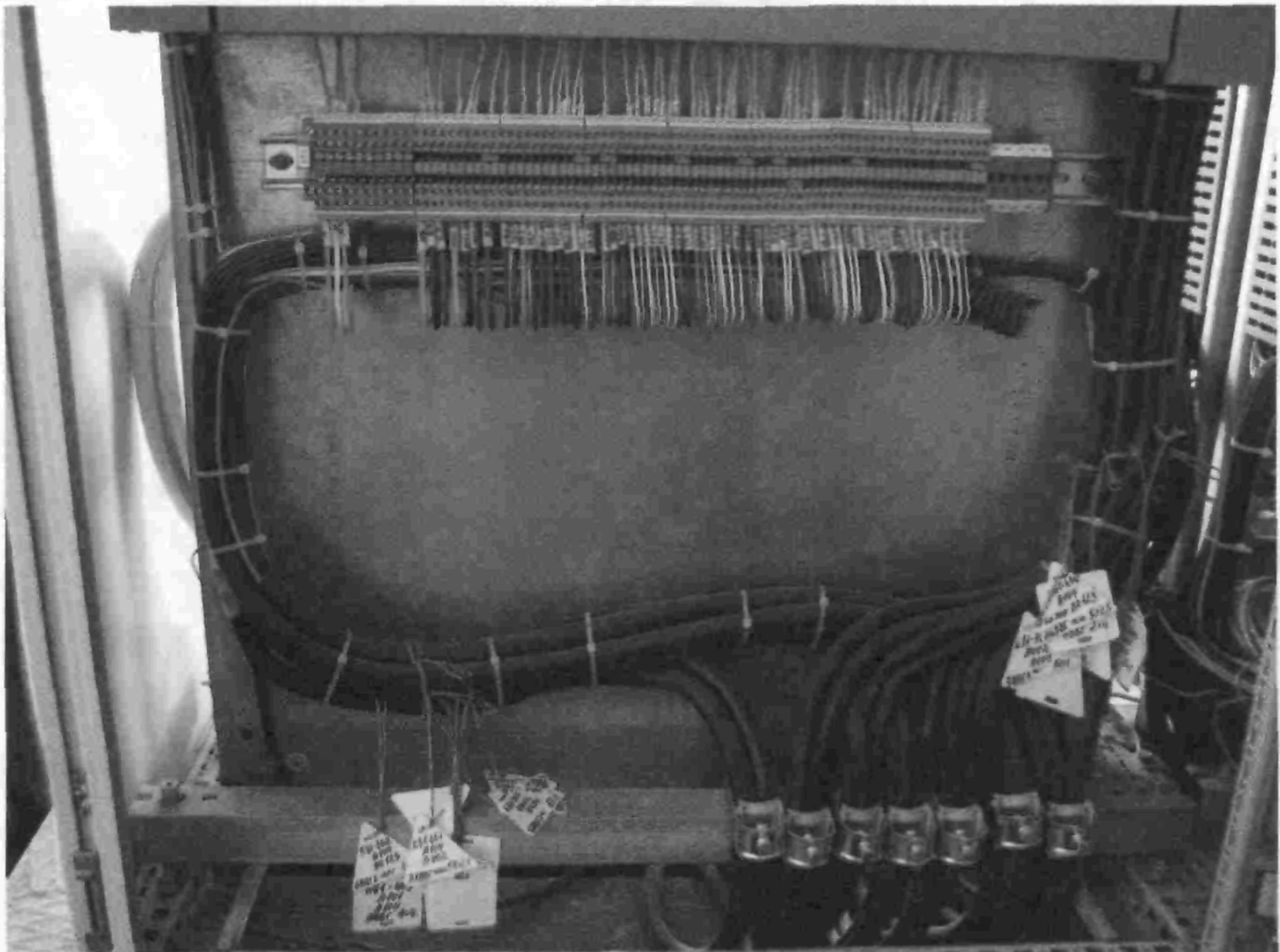
Рис. 8.1.1. Подвод контрольных кабелей снизу электроконструкции
