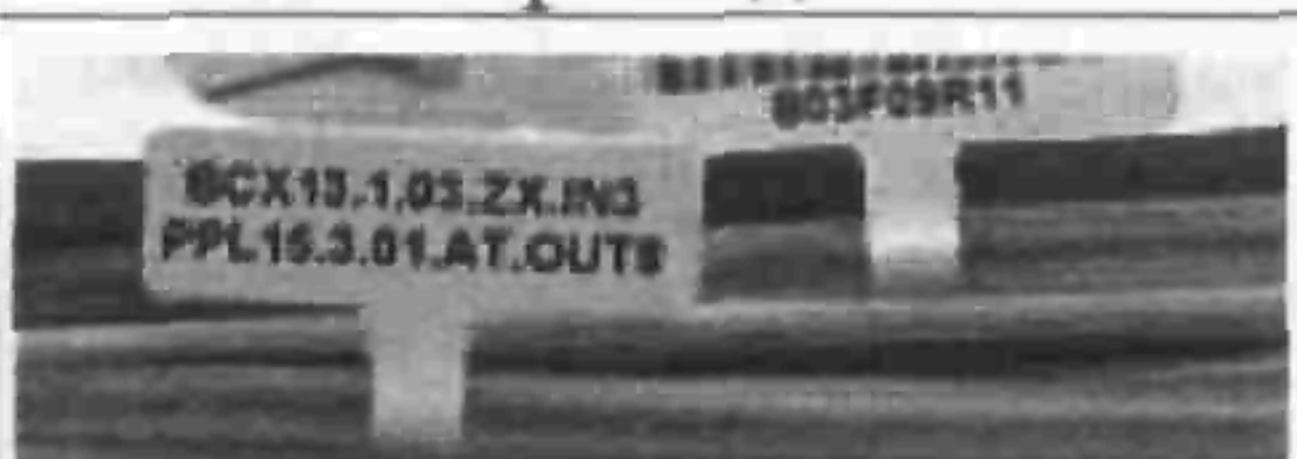
Рис. 9.2.6. Флажки Р и Т формы для кабеля и провода
