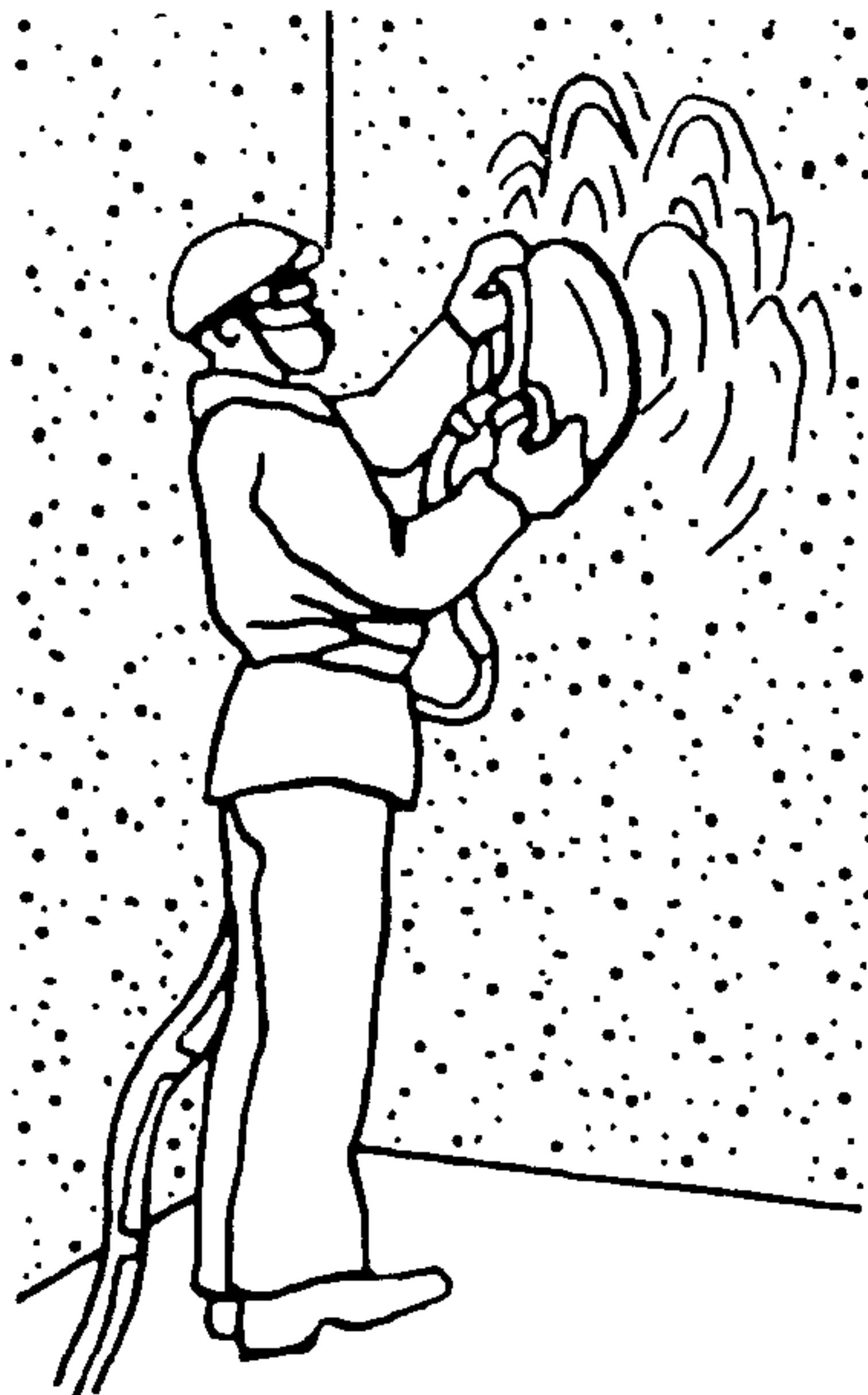
Рисунок 4 – Механизированная затирка поверхности.
