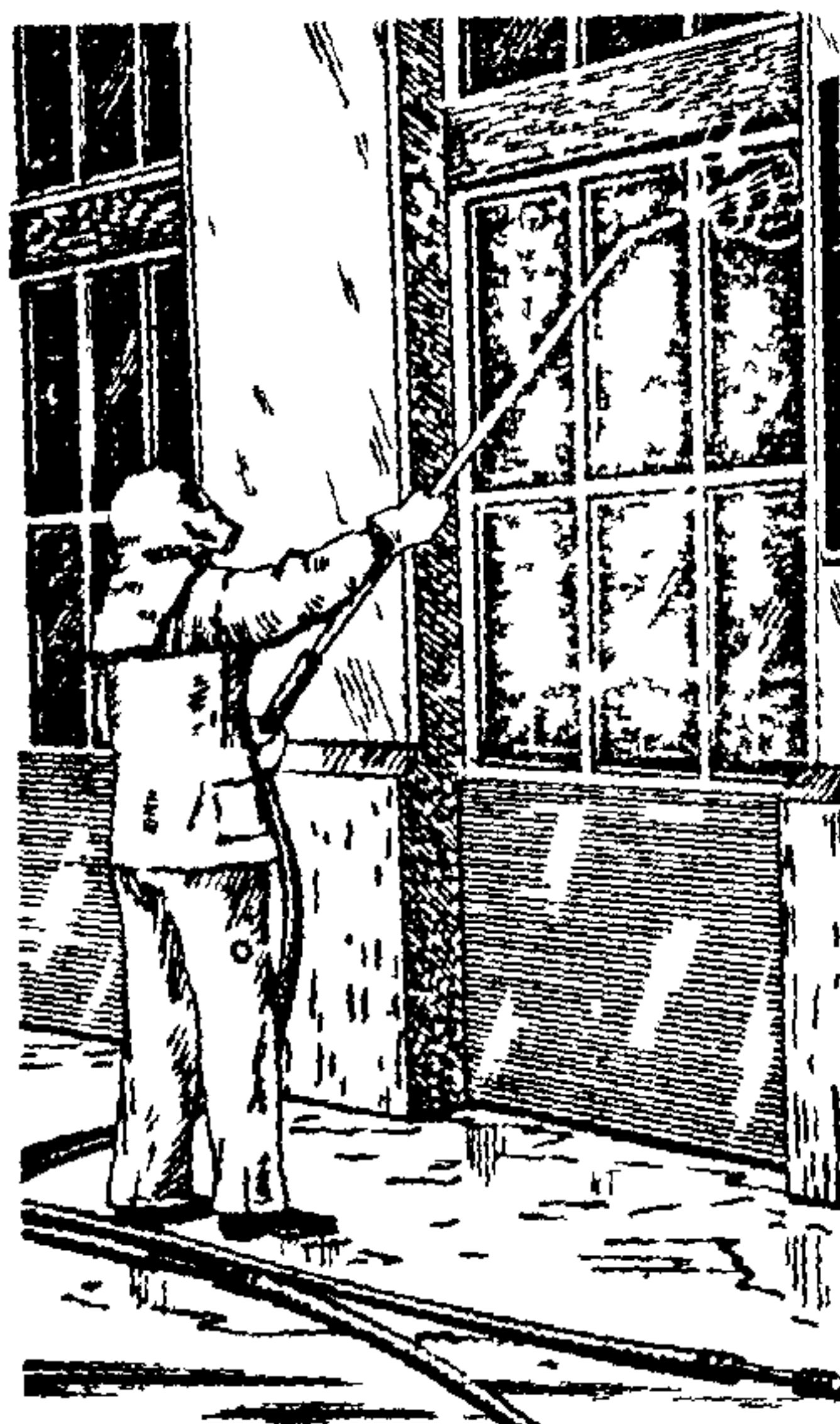
Рис.2. Пескоструйная очистка фасада.
