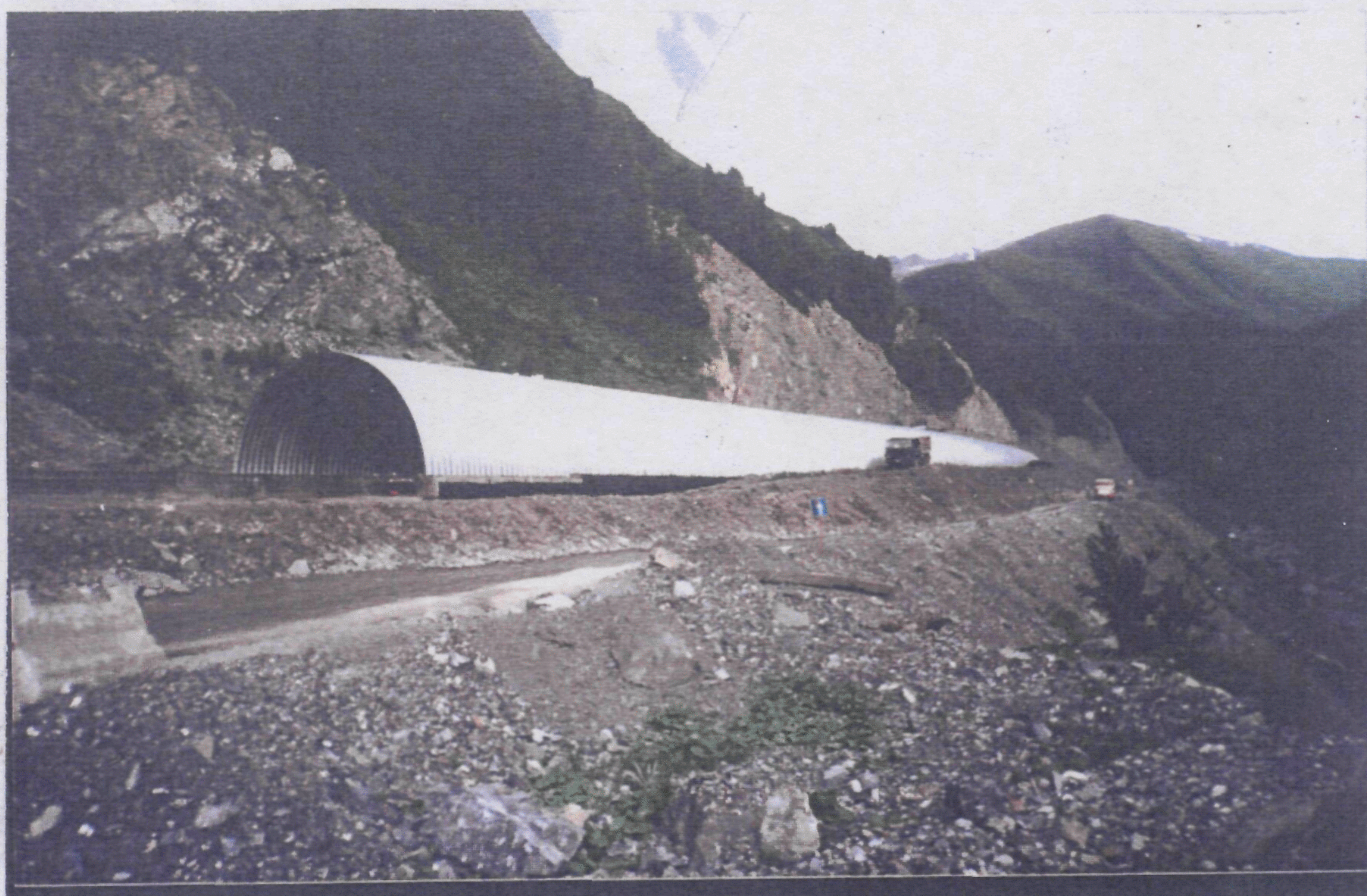
Фото 5. Строительство лавинозащитной галереи вблизи Рокского перевала (фото А.А. Махорина)
