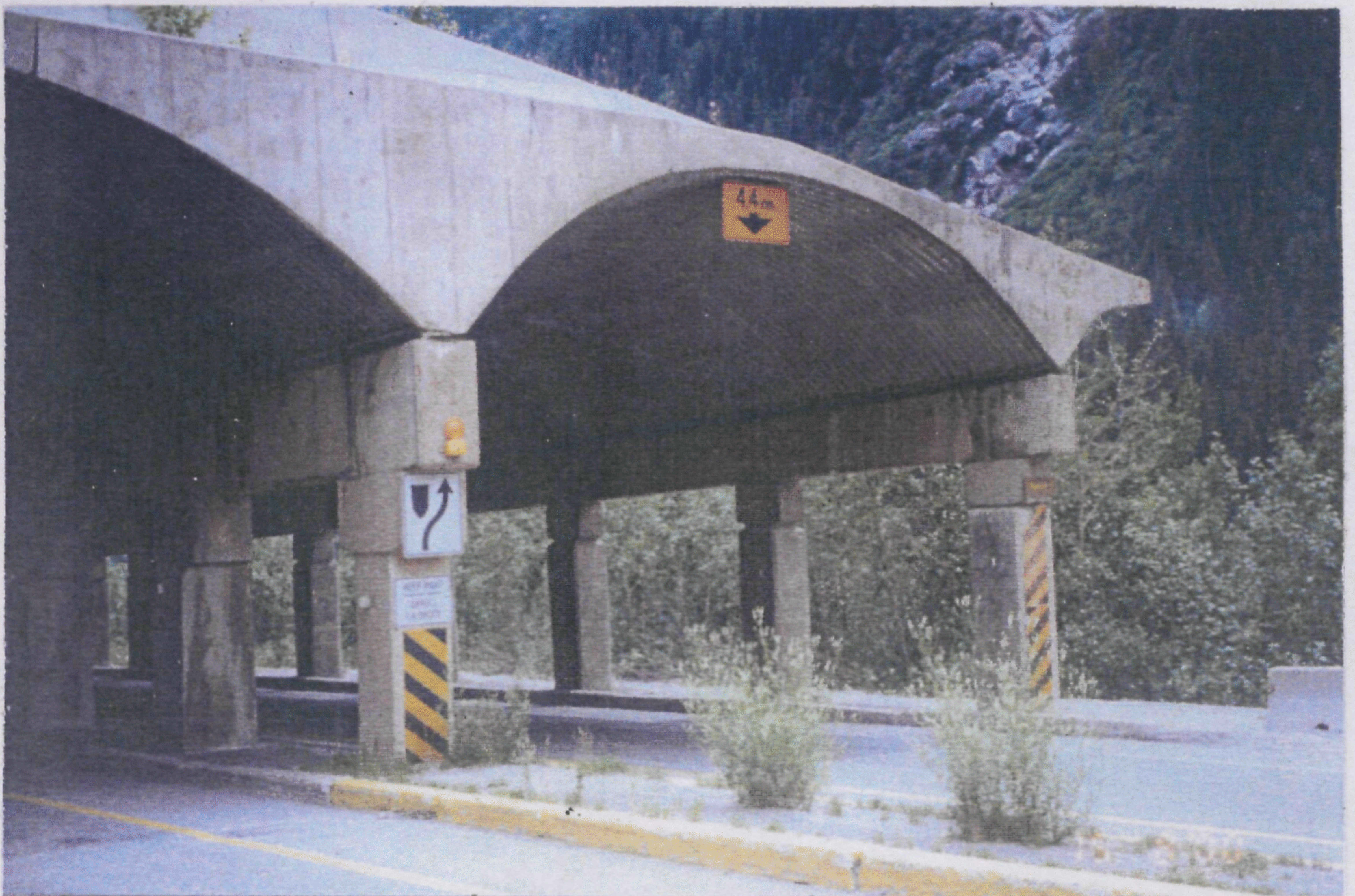
Фото 4. Лавинозащитная галерея со сводом из ГМК
