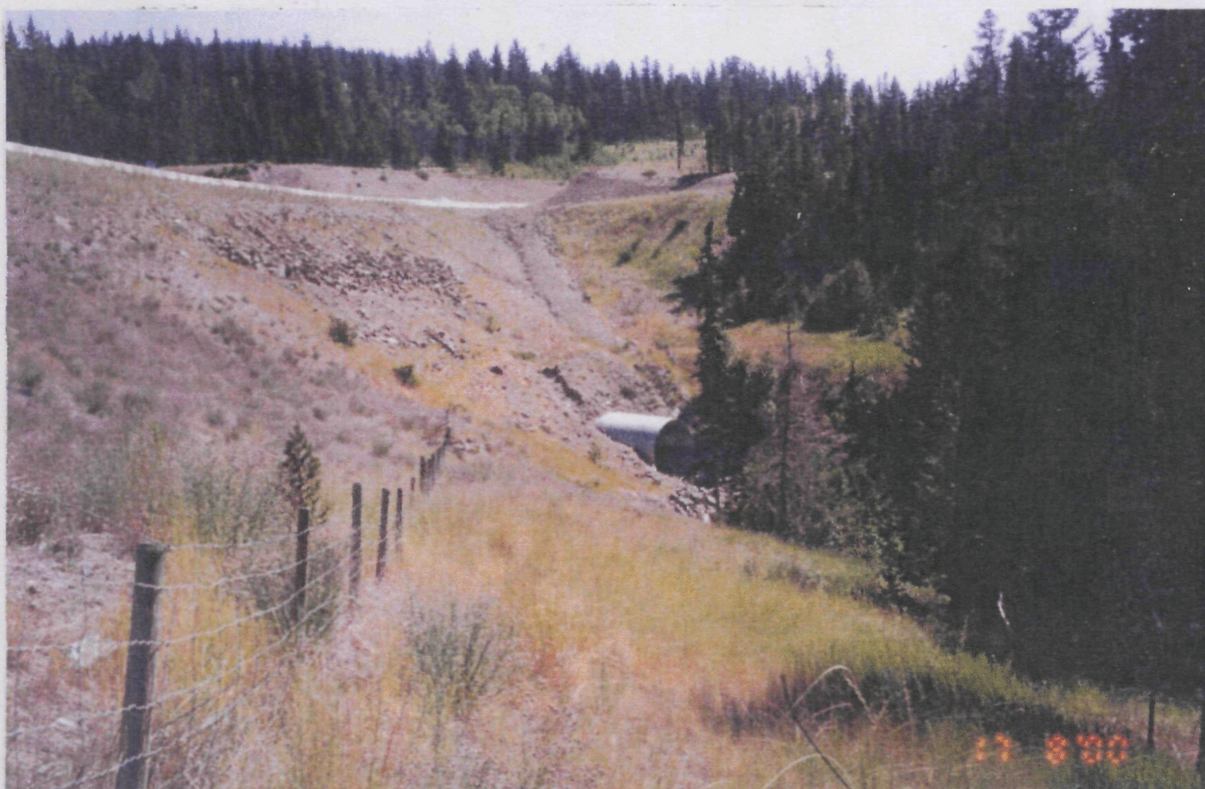
Фото 1. Труба большого диаметра под насыпью автомобильной дороги
