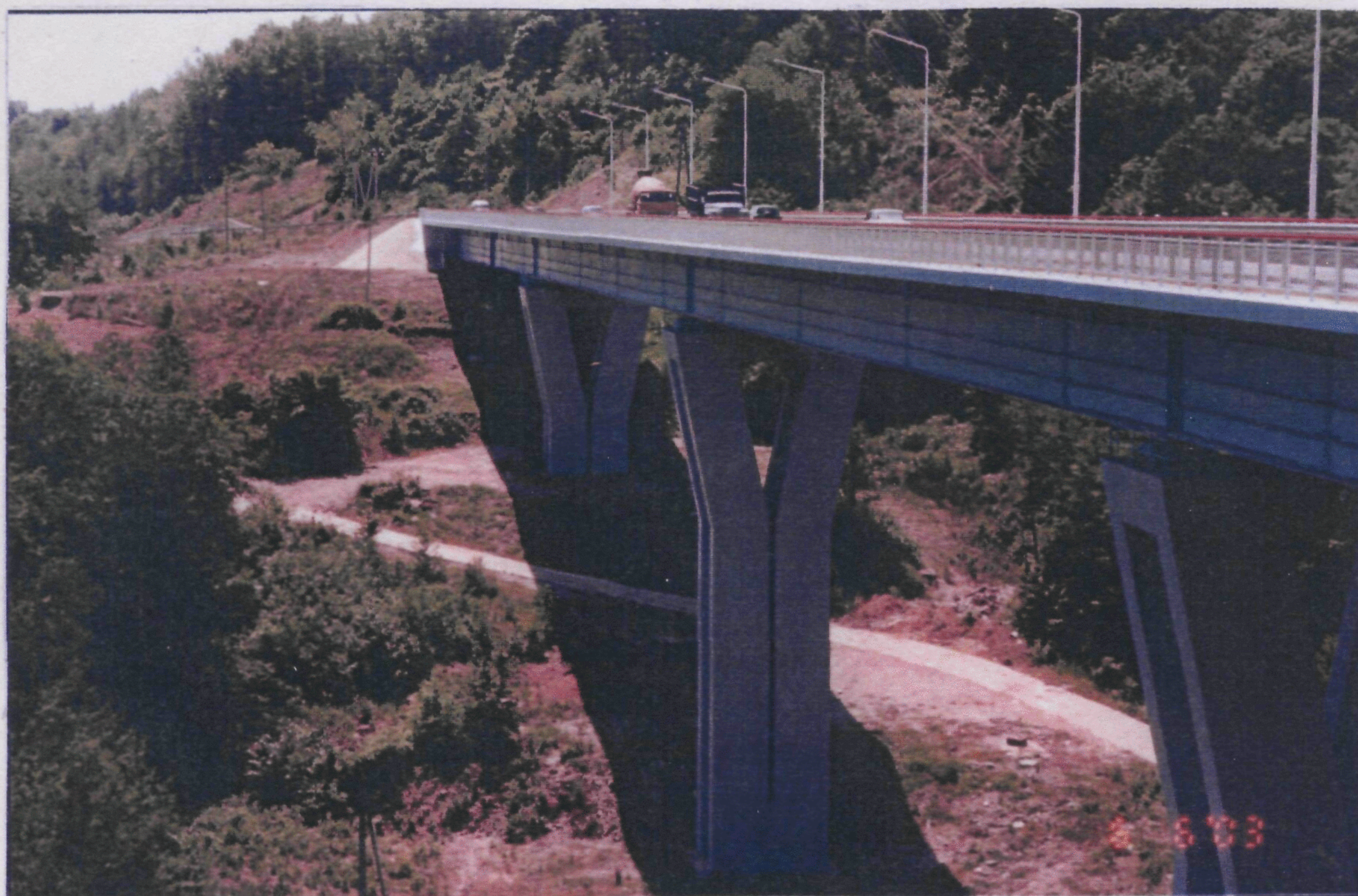
Фото 8. Виадук на ПК36 обхода г. Сочи
